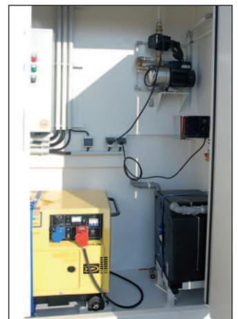
Technikraum mit Ventilator, Schaltschrank und Notstromaggregat
